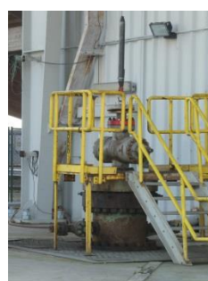
Bohrloch 9.101 m tief mit "Preventer" gedeckelt
